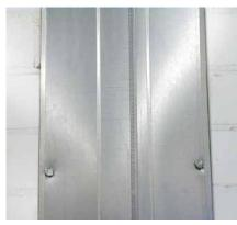
PYRODOM®-BWF kommt an massiven Wänden und Decken aus Mauerwerk, Beton oder Porenbeton mit einer Mindestdicke von 150 mm zum Einsatz. Das Brandschutz-Fugensystem wird auf beiden Seiten der Wand oder Decke montiert. Es besteht aus einem speziellen Brandschutzgewebe und einer metallischen Außenabdeckung zum
