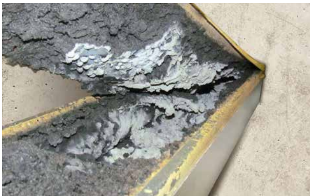
Aufgeschäumter Dämmschichtbildner im Inneren des Kabelkanals verhindert Brandausbreitung
