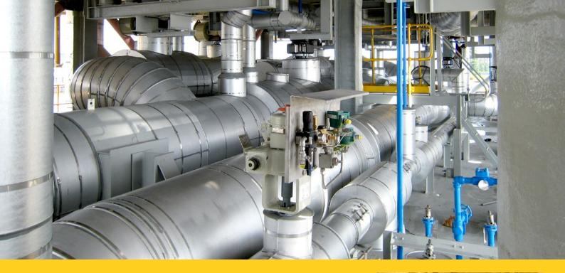
Um die aufwändigen Arbeitsprozesse so effektiv wie möglich zu gestalten, isolierte G+H Insulation die Module komplett in einer Vorfertigungshalle von Hollandia in Krimpen (Niederlande). Die fertigen Einheiten wurden bauseits per Schiff an ihren Bestimmungsort in England transportiert. Da auf den Modulen eine Vielzahl von Rohrleitungen und Equipment nebenund übereinander verlegt sind, musste die Tiefkälteisolierung auf sehr engem Raum vorgenommen werden. Dafür
