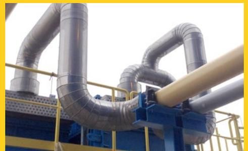
Um Temperaturen von bis zu -196 Grad standzuhalten, bei denen das Gas verflüssigt wird, kamen für die Isolierung der Rohrleitungen und Behälter zwei bis drei Lagen PIR-Schalen mit einer inneren Dampfbremse aus Aluminiumfolie zum Einsatz. Danach folgte eine Lage Foamglasschalen sowie eine äußere Dampfbremse aus Aluminium-Bitumenfolie. Sämtliche Schalen wurden passgenau vorgefertigt. Die anschlie-
