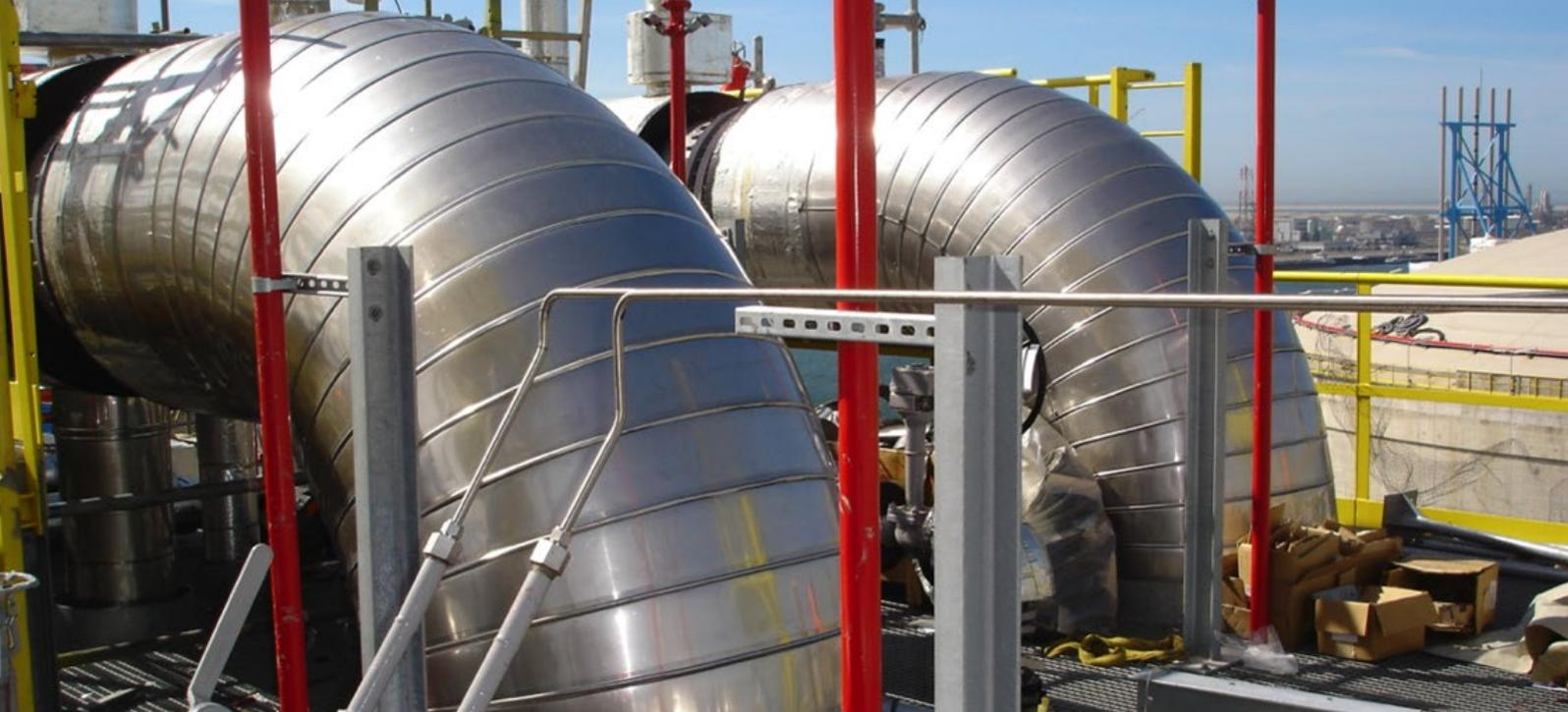
Zu Beginn des anspruchsvollen Projekts legte G+H eine drei- bis vierlagige Kombi-Isolierung (150 bis 200 mm) mit vorgefertigten PIR-Schalen bzw. Foamglasschalen zum Kälteschutz um die Tankrohrleitungen des Terminals. An verengten Stellen brachten sie bis zu acht Lagen Cryogel-Z-Matten mit einer Dicke von 10 mm je Lage an. Die innere und äußere Dampfbremse verklebten die Monteure mit verstärkter Aluminiumfolie und Aluminium-Bitumenfolie, die vor Korrosion und dem Eindringen von Feuchtigkeit
