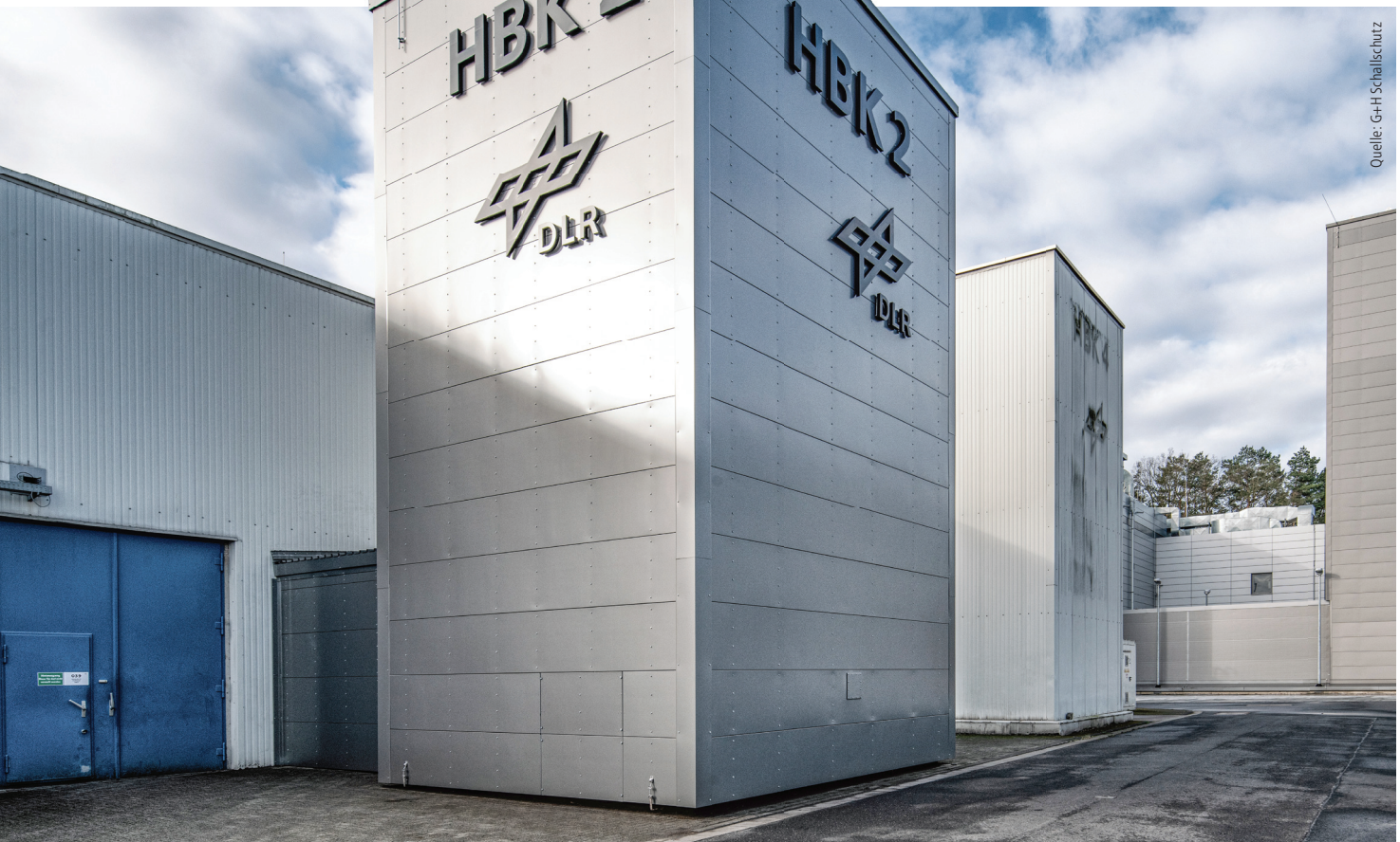
Der Hochdruck-Brennkammer-Prüfstand 2 (HBK2) des DLR wurde mit einem neuen Schalldämpfer und einer Strömungsumlenkung ausgestattet.
