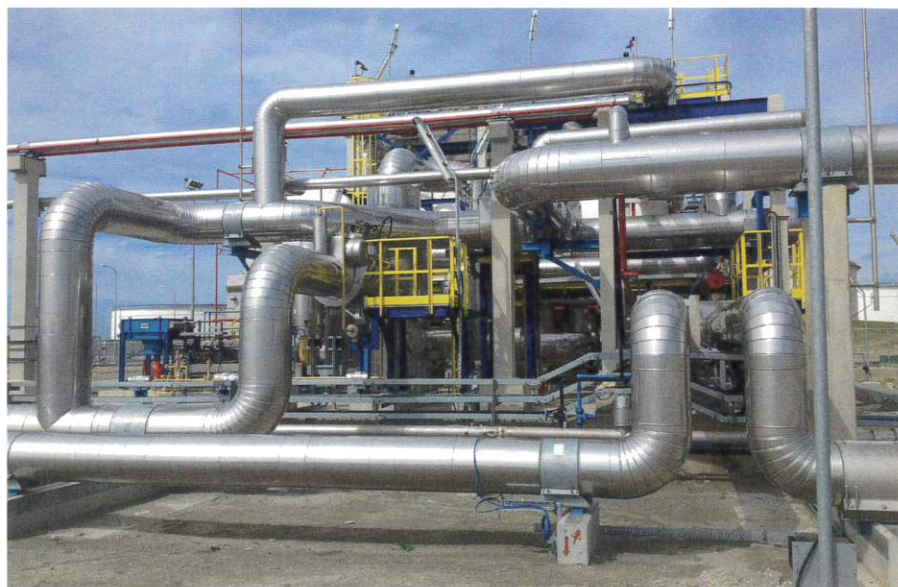
Aufgrund des Wittereinflusses sind Raffinerien für Isolierbetriebe eine wartungsintensive Umgebung.
