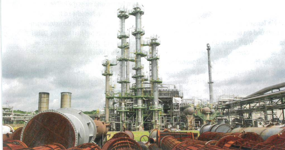
Isolierung auf der Höhe: Wärmetauscher-Kolonnen können in Raffinerien bis zu 70 m hoch sein.
