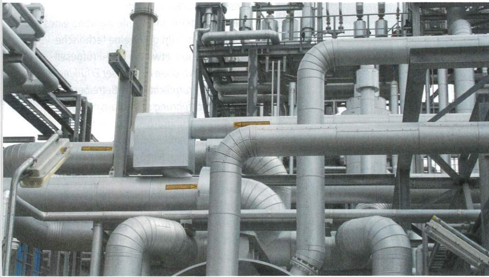
Anlagen bestehen aus verzweigten Rohrsystemen, weshalb z.T. an schwer zugänglichen Stellen isoliert wird.
