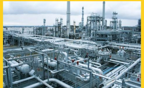
Die Isolierer von G+H legten Mineralwolle-matten mit RAL-Gütezeichen um die zu dämmenden Bauteile, die Temperaturen bis zu 600 Grad standhalten. Danach verkleideten die Monteure diese vollständig mit einer Alu-Zinkverblechung. Die benötigten Metallteile wurden vor Ort angefertigt. Darüber hinaus stattete G+H sämtliche Stahlbaukonstruktionen in feuergefährdeten Bereichen der Raffinerie mit Brandschutzlösungen aus. Damit die Trag-
