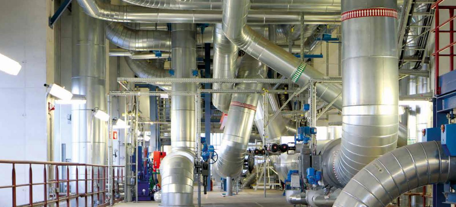
G+H setzte die Wärmeisolierung an HD-, MD- und ND-Rohrleitungen um sowie die elektrische Begleitheizung inklusive der Verkabelung und Schaltschränke. Als begleitende Schallschutzmaßnahme erhielt der Transformator eine spezielle Einhausung. Für die senkrechten HD-Fallrohre kam eine eigens von G+H entwickelte Unterkonstruktion aus hochwertigen Edelstählen zum Einsatz, die auf Nocken aufgehängt wurde. Diese verhindert das Verrutschen der Isolierung und somit einen Hitzedurchschlag.
