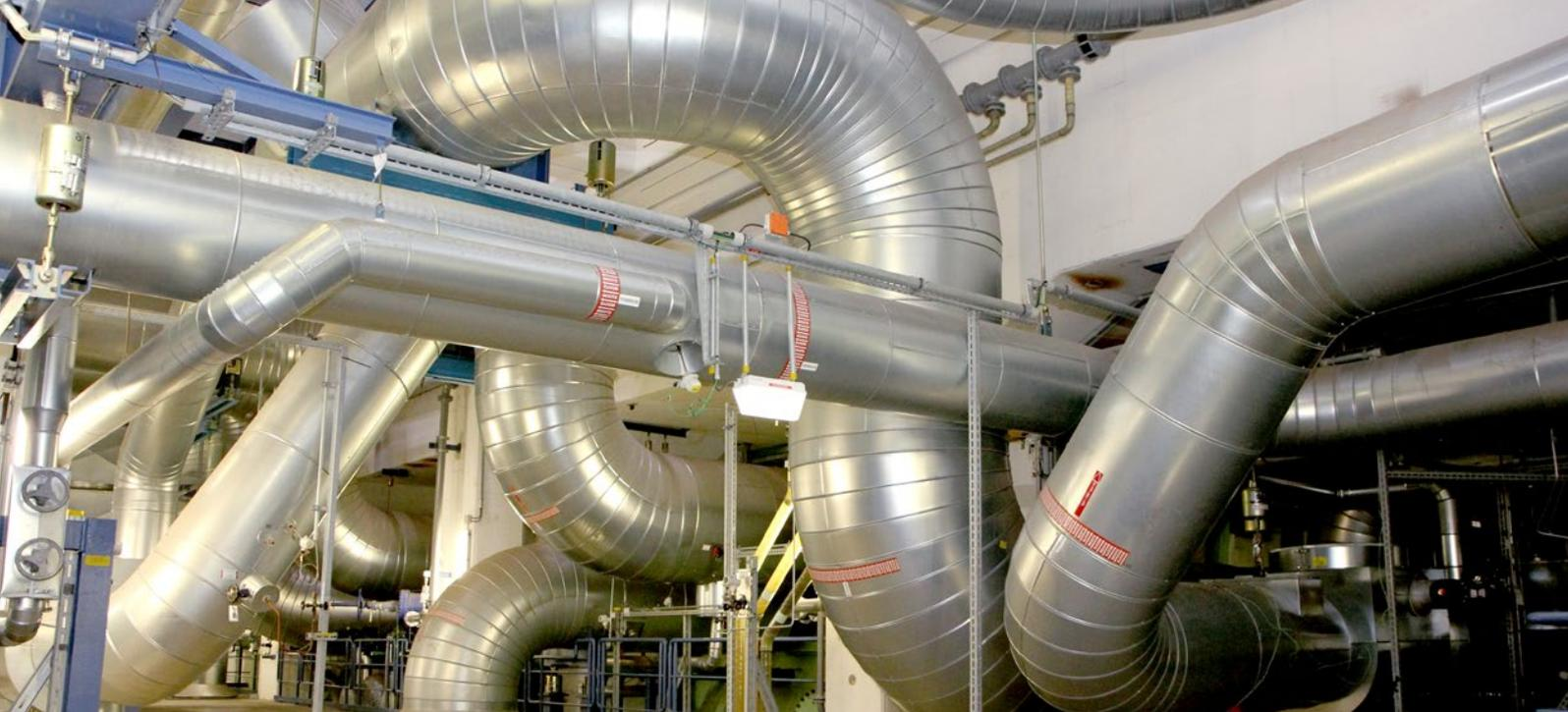
Alle Behälter im Kessel- und Maschinenhaus sowie die außen liegenden Rohrleitungen wurden von G+H mit einer Wärme- und Schallisolierung versehen. Eine Herausforderung war die Isolierung an den bis zu 80 Meter vertikal verlaufenden Hochdruckleitungen durch mehrlagige Dämmstoffe mit Sondermaterialien wie CMS-Fasern. Häufig werden Isolierungen über Doppelspannringe fixiert. Bei den extrem hohen Temperaturen und den dicken
