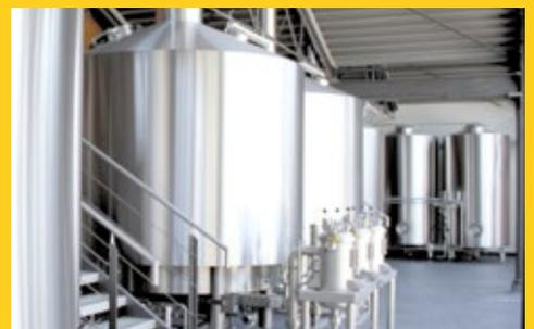
An allen Wärmebehältern mit einem Durchmesser von 1.000 bis 2.500 mm montierten die Isolierer von G+H aluminiumbeschichtete, 100 mm dicke Mineralwolle. Die abschließende Verkleidung besteht aus beschichtetem Aluminium-Glattsblech. Die Laugen- und CIP-Tanks verkleideten die Monteure mit 0,6 mm dickem Edelstahl-Glattsblech. Für alle warmgehenden Rohrleitungen innerhalb des Sudraumes mit einem Durchmesser von DN
