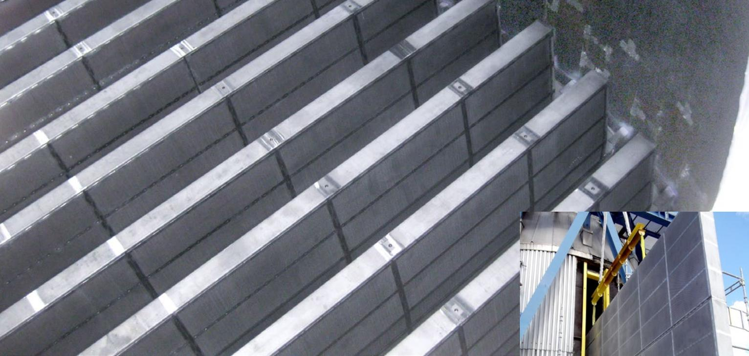
Der Einbau von Schalldämpferkulissen in Abgassystemen sorgt für die akustische Betriebssicherheit von Kraftwerken, ohne die aus den Gasturbinen austretenden Luftströme zu behindern. Der Austausch beschädigter Kulissen ist essenziell, um diesen akustischen, aber auch mechanischen Schutz aufrechtzuerhalten. Die bis zu sieben mal acht Meter großen Kulissen im Kraftwerk Halmstad befinden sich im Schalldämpfergehäuse unterhalb der
