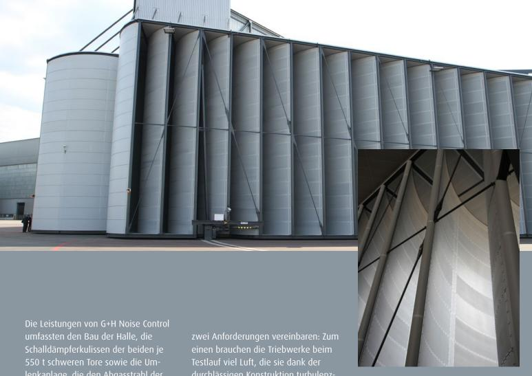
Die Leistungen von G+H Noise Control umfassten den Bau der Halle, die Schalldämpferkulissen der beiden je 550 t schweren Tore sowie die Umlenkanlage, die den Abgasstrahl der Flugzeugtriebwerke hinter der Halle nach oben lenkt. Das Dach wird über eine außenliegende Stahlkonstruktion aus räumlichen und ebenen Fachwerken sowie Aussteifungsverbänden über eine maximale Spannweite von circa 78 m stützenfrei getragen. Durch diesen speziellen Hallenaufbau lassen sich
