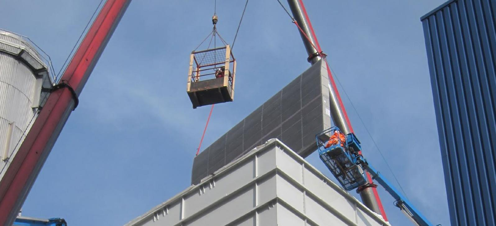
Um das Gas- und Dampfkraftwerk Vilvoorde auf den Einsatz als Reservekraftwerk vorzubereiten, wurde zunächst der Kessel außer Betrieb genommen. G+H installierte dazu eine Absperrplatte zwischen Gasturbine und Kessel und in einem zweiten Schritt einen 45 m hohen Bypass-Kamin, durch den die Abgase jetzt entweichen. Hierdurch lässt sich das Kraftwerk schneller anfahren. Der im Kamin integrierte Schalldämpfer mit mehreren 10 x 10 m großen Kulissen erfüllt dabei sicher
