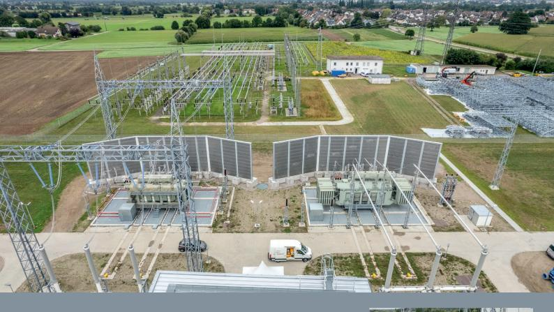
Um den Lärmschutz zu verbessern, kamen im UW in Weier zwei SONEX®-T-Abschirmwände von G+H Noise Control mit einer Gesamtlänge von 33 Metern und einer Höhe von 8,5 Metern zum Einsatz. Die einzelnen Elemente der Abschirmwände werden in eine spezielle Tragekonstruktion eingefügt und lassen sich so an jede örtliche Gegebenheit anpassen. Das ermöglicht eine einfache und schnelle Montage der Vollwandelemente. Sie sind 120 Millimeter stark und entsprechen dem be-
