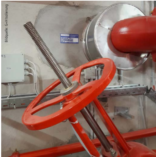
Abb. 3: asymmetrische Rohrabschottung G+H Isolierung nach AbP P-MPA-E-00-019
