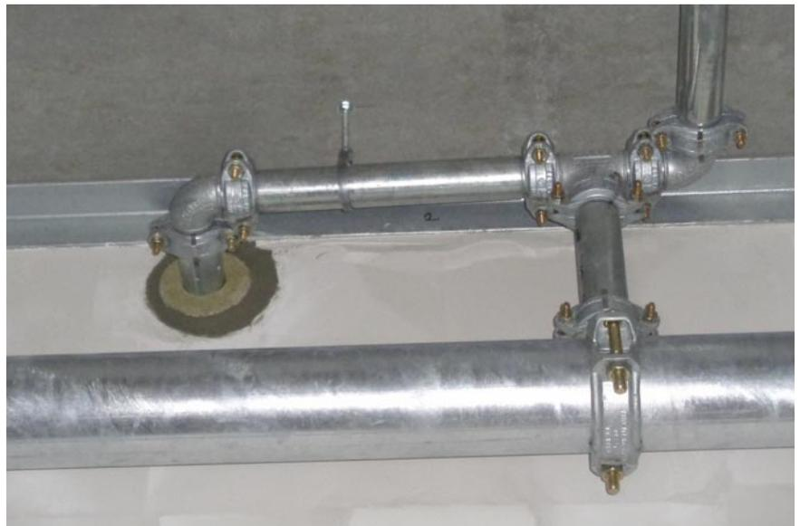
*Ausführung nach MLAR, Restspaltverschluss mit Mineralwollschalle  $\leq 50$  mm und Mörtel*
