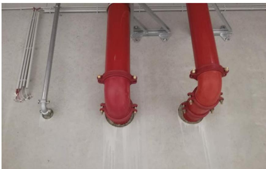
*Ausführung mit Nachweis, Ausgangssituation: Rohre in DN 250, Ringspalt zu klein und „Verbin- derststellen“*
