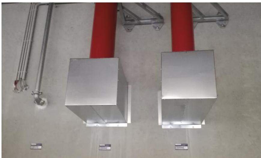
*Ausführung mit Nachweis, Ausführung mit Mineralwollisolierung, intumeszierender Bandage und Blechumhüllung*
