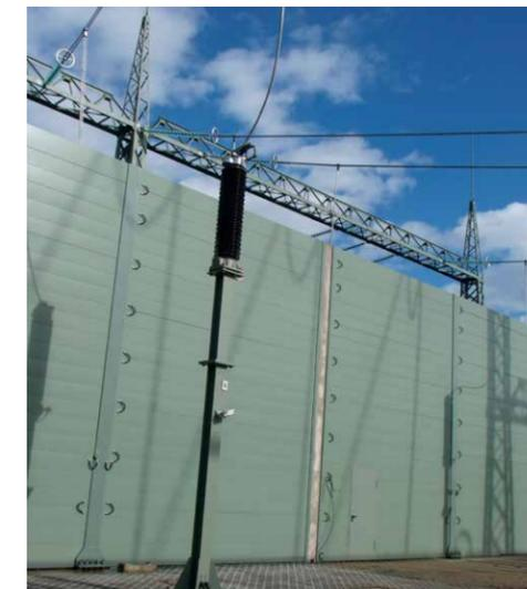
Abschirmwand: Ein Rahmengerüst aus Doppel-T-Trägern, Profilstählen und Kantteilen nimmt die Wandelemente auf. (Foto: G+H Noise Control)
