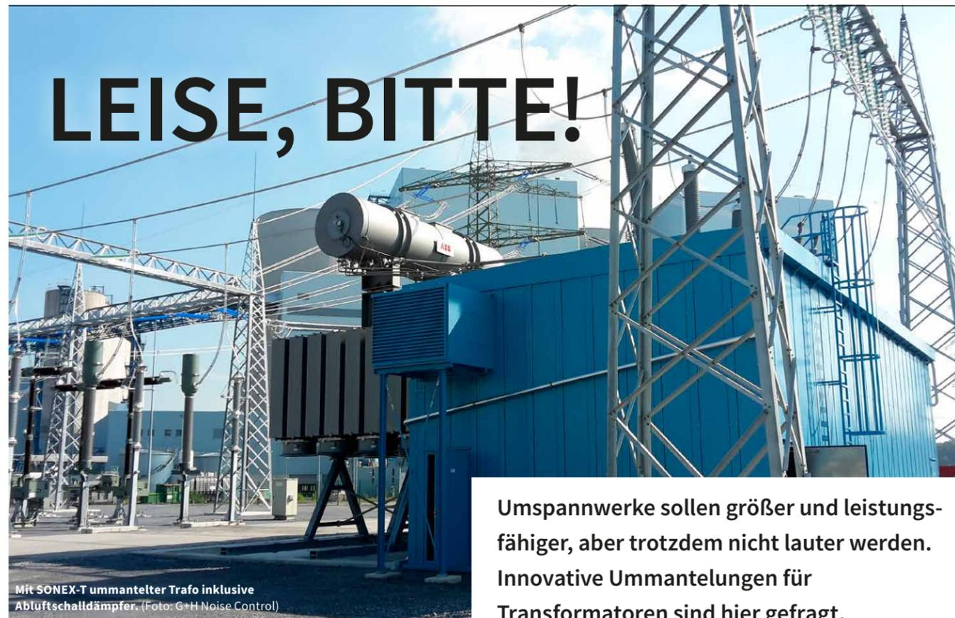
Mit SONEX-T ummantelter Trafo inklusive Abluftschalldämpfer. (Foto: G+H Noise Control)
