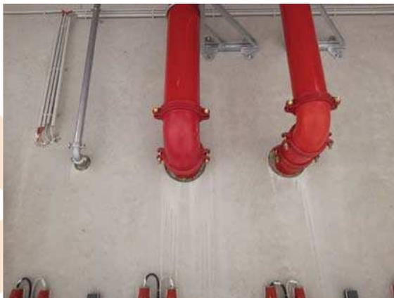
Ausführung mit Nachweis, Ausgangssituation: Rohre in DN 250, Ringspalt zu klein und „Verbinderstörstellen“
