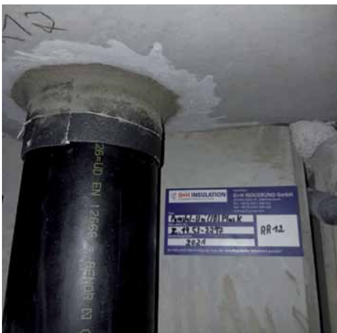
Rohrabschottung PYROSTAT-UNI für Kunststoffrohre eingebaut
