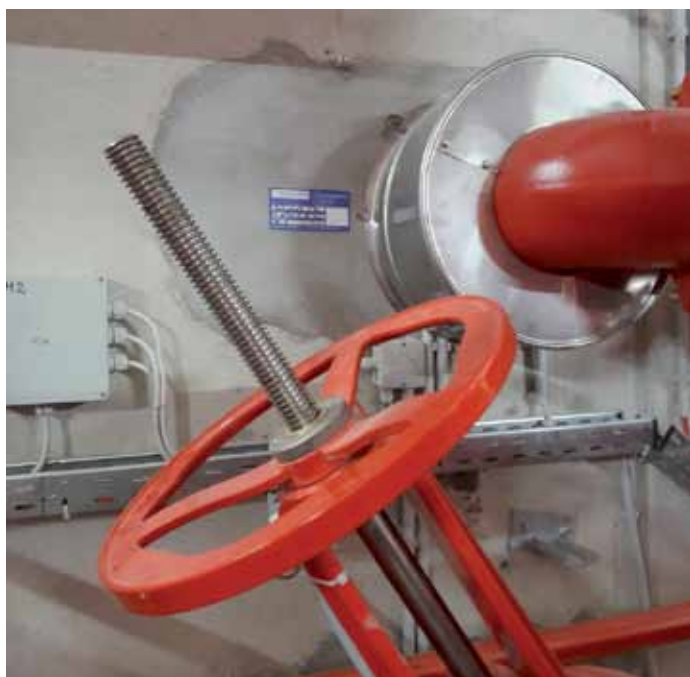
asymmetrische Rohrabschottung G+H Isolierung nach AbP P-MPA-E-00-019
