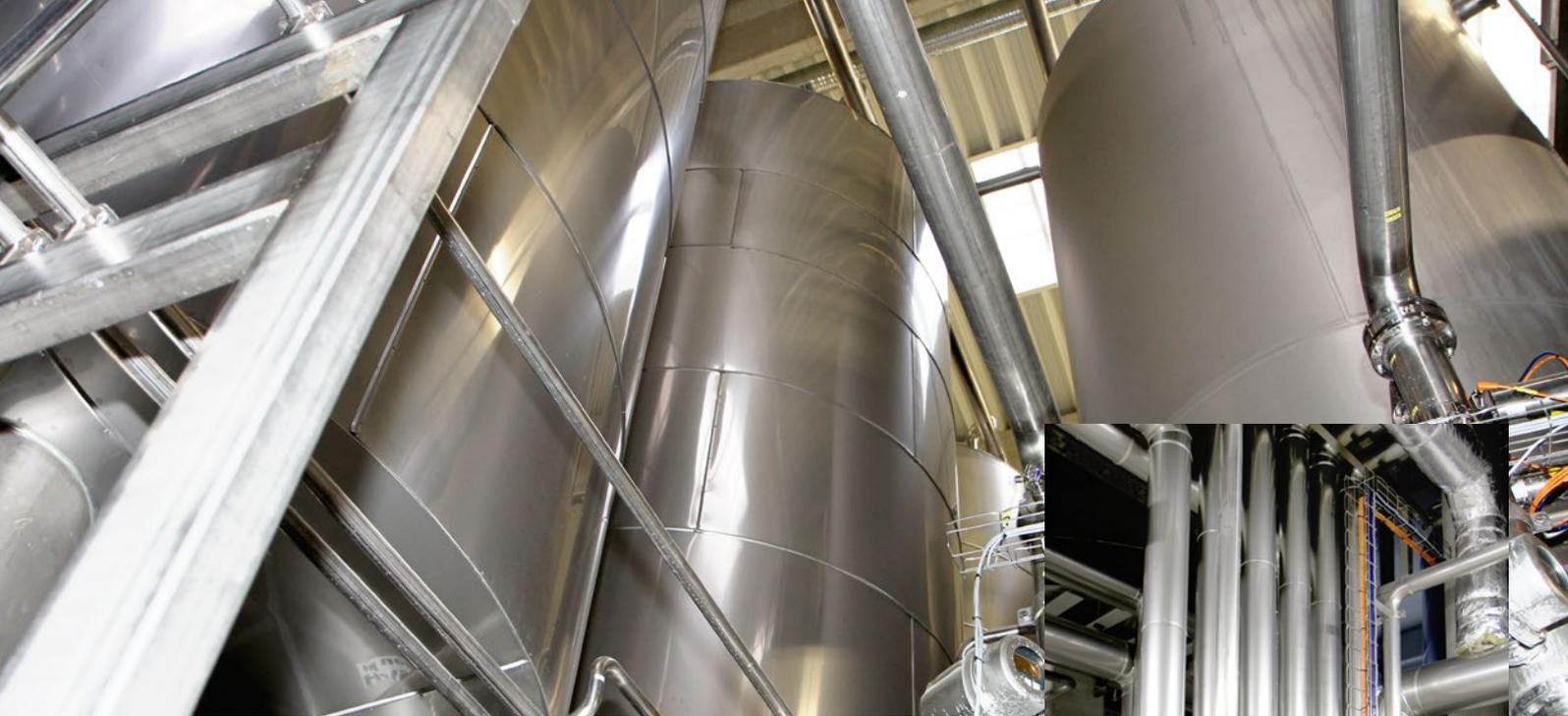
Die Isolierung umfasste zwei Sudlinien mit fast 30 Behältern und kilometerlangen Rohrleitungen. Für die Tanks wählte G+H Insulation Mineralwolle mit einer Isolierstärke von ca. 100 bis 120 mm sowie Polyurethan (PUR)-Ortschaum. Eine Edelstahlverblechung sorgt für den nötigen Oberflächenschutz. Bei den Rohrleitungen kamen unterschiedliche Isolierverfahren zum Einsatz: So nutzte das Team Mineralwolle für die Warmleitungen sowie Polyurethan (PUR)-Ortschaum und eine
