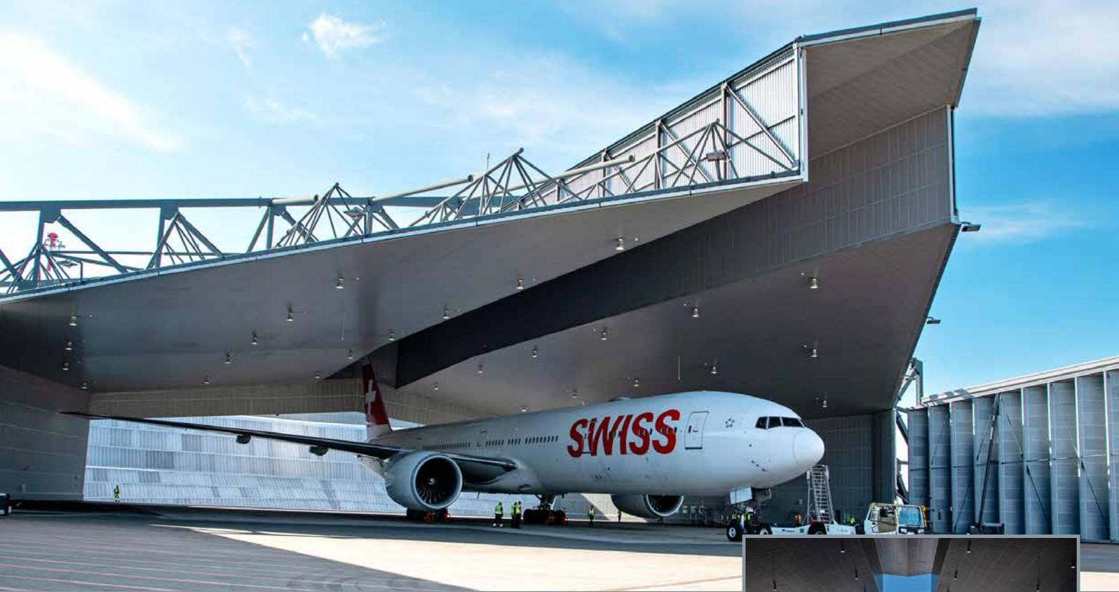
Die Sekundärkonstruktion der Strahlumlenkung wurde im Bereich der senkrecht zum Triebwerkstrahl orientierten, schrägen Flächen neu gebaut. Die Verstärkung der Primärkonstruktion erfolgte durch die Anbringung zusätzlicher 2,2 to Pfettenlagen. Als Sickenfüller für die 1.050 m<sup>2</sup> Trapezblech wurden 1.050 m<sup>2</sup> Mineralwolle verbaut. Für die Lärmschutzhalle hat G+H 222 hochabsorbierende Schallschutzelemente aus 3,0 mm – sowie 218 Stück
