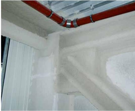
Stahltragwerk eines Dachstuhls mit Vermiculiteputz F 90 beschichtet
