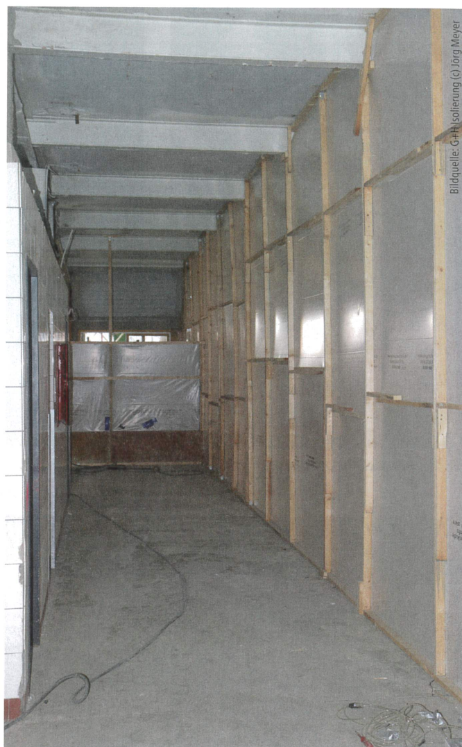
Mit Holzrahmen und Folien abgeschotteter „Schwarzbereich“
