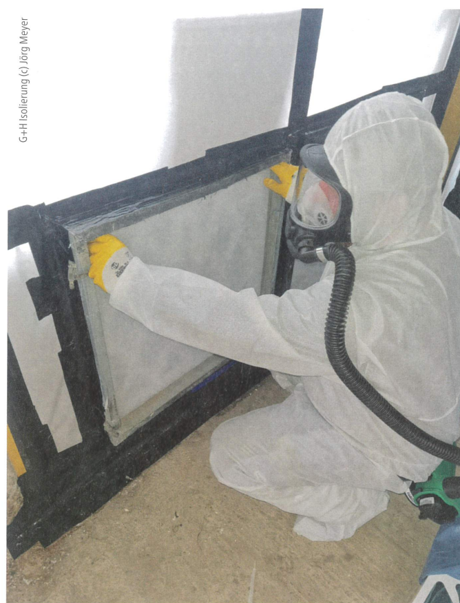
Austausch eines Filters der lufttechnischen Anlage
