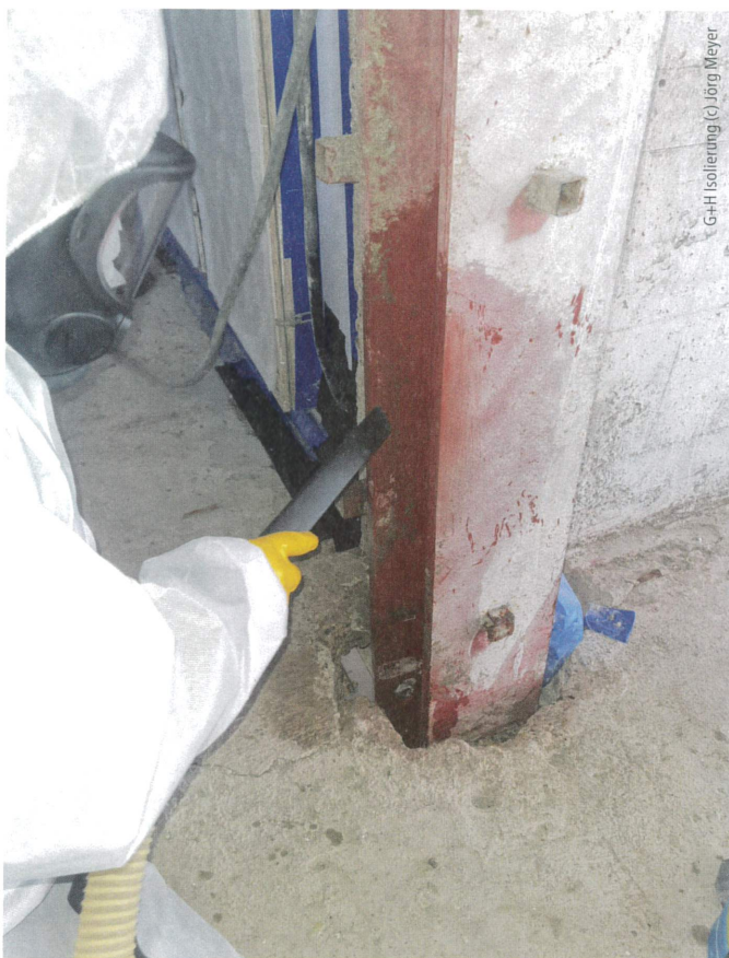
Reinigung: Mit Spezialsaugern werden verbliebene Asbestfasern zuverlässig entfernt.
