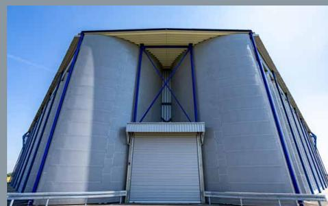
Um die bestehende Lärmschutzhalle auszubauen, demontierte das Team der G+H Noise Control die Giebelwand und integrierte sechs neue Kulissenwände, analog zu den bestehenden Kulissenwänden in den Giebelwandbereich. Dieser war bis zu den Umbauten stirnseitig mit Akustikpaneelen geschlossen. Zudem erfolgte die Erweiterung der Schallschutz-
