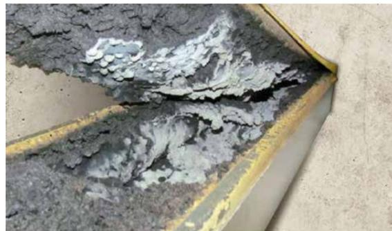
Aufgeschäumter Dämmschichtbildner im Inneren des Kabelkanals verhindert Brandausbreitung
