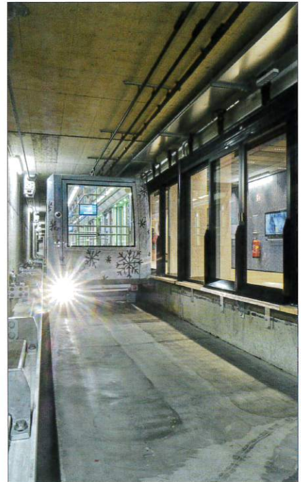
G+H unterstützte beim Umbau des U-Bahntunnels Serfaus.
