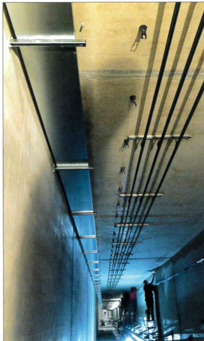
Der innovative Elektroinstallationskanal verhindert die Brandweiterleitung innerhalb der Kanäle.
