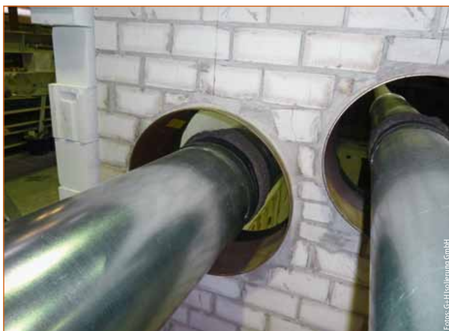
Abb. 1: Aufbau des Brandversuchs am 11. April 2012: Das Schiebelement ist montiert.
