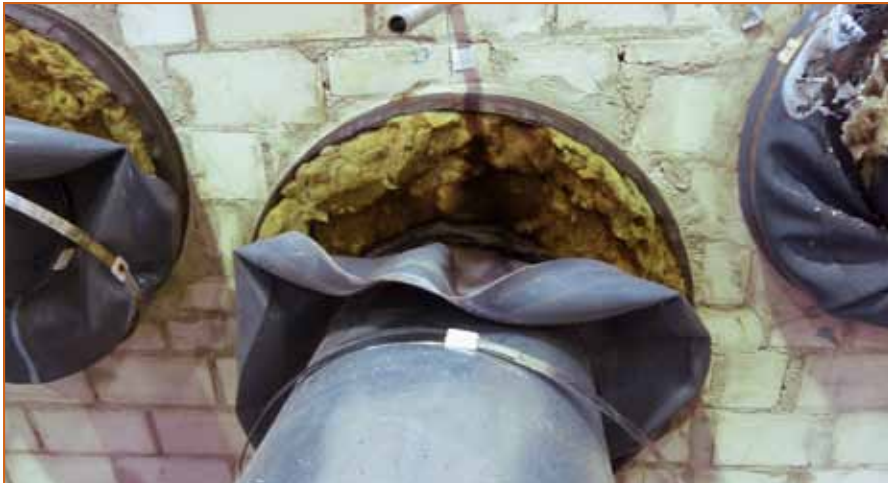
Abb. 4: Nach dem Brandversuch am 11. April 2012: Ansicht Feuerseite: alles verschlossen
