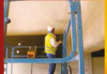
Messung der Schichtdicken während und nach der Beschichtung
