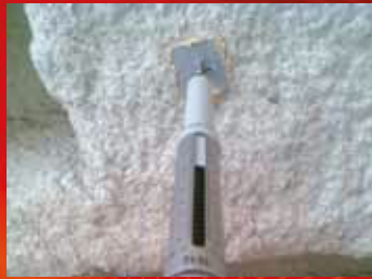
Die Haftzugfestigkeit wird abschließend kontrolliert
