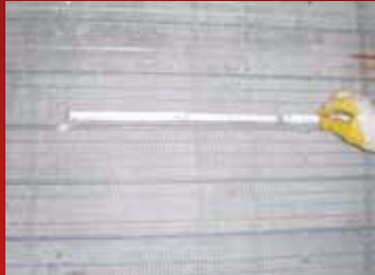
Dübelabstände werden während und nach der Montage überprüft
