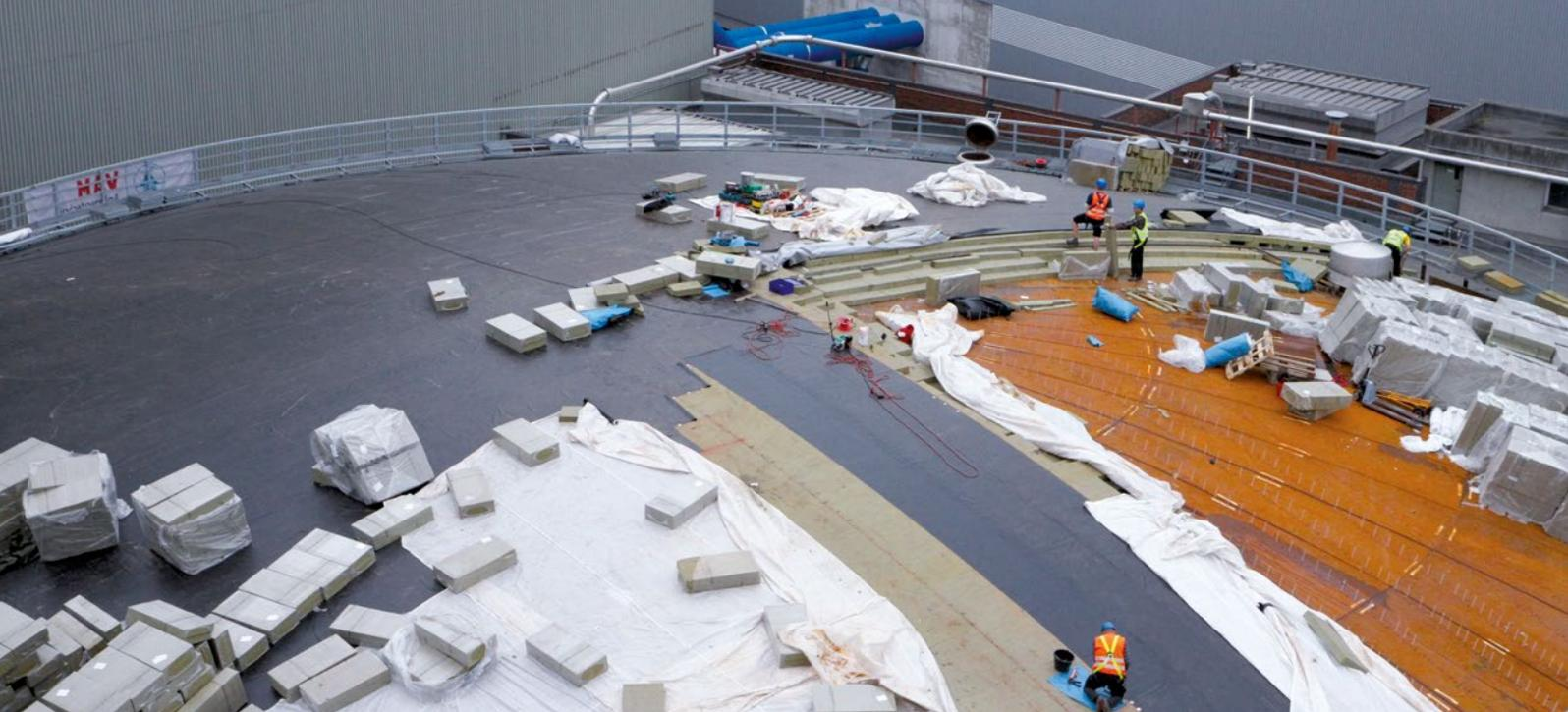
Im Rahmen der Realisierung des neuen Fernwärmespeichers im sogenannten „Dr.-Hedbäck-System“ (benannt nach dem schwedischen Ingenieur Dr. Anders Hedbäck) wurde die W&N-Niederlassung Maxdorf mit der Isolierung des Speicherdachs sowie der Wände beauftragt. Während der Behältermontage isolierten die Monteure das 40 m breite Speicherdach mit druckfesten Dachdämmplatten und verkleideten es mit Kunststoffbahnen in Dachdeckerqualität. Anschließend dämmte W&N die Wände des Speichers
